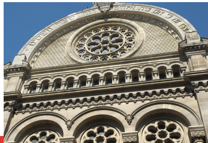
Fassade der Großen Synagoge
